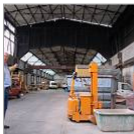
In einer Halle auf dem Gelände des Walzwerks möchte der Pulheimer Rüdiger Schmidt-Holzmann ein Hotel mit 43 Zimmern bauen. BILDER: MMA
